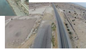
2da calzada carretera Piura-Paita
