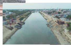
Puente Juan Pablo II (Piura)
