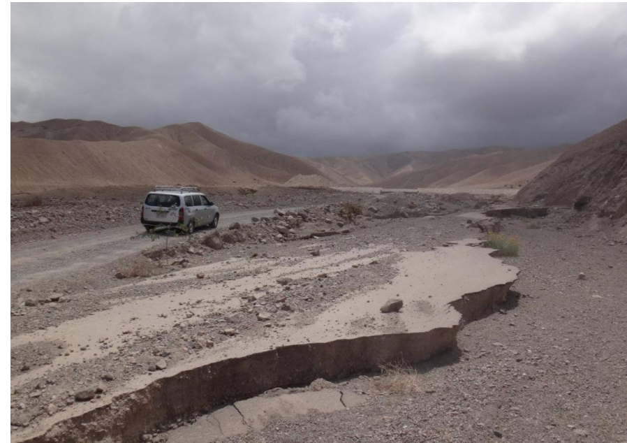
Vista hacia aguas arriba. Erosión de la carretera producida por flujos detríticos.
